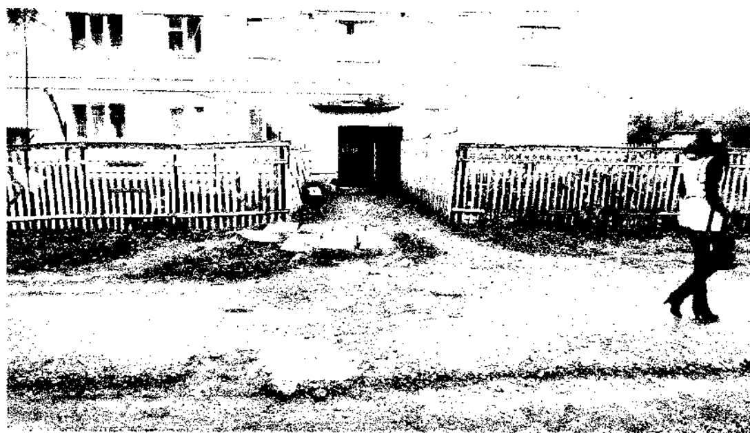
Рис. 2. Состояние проезда ул. Школьная, д. 8,10,12,14
