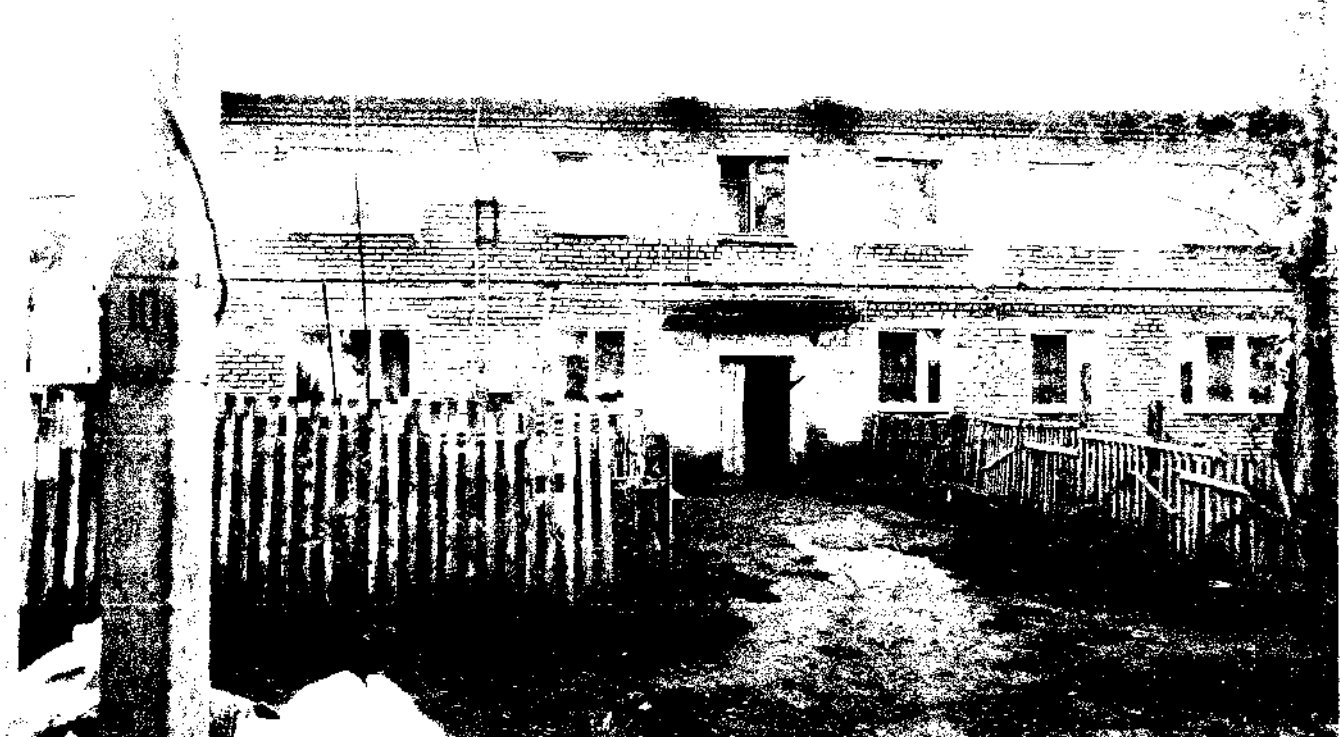
Рис.6. Деревянный забор деформирован, местами отсутствует ул. Школьная, д.12
